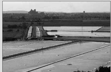
Narbonne vue depuis les bassins de décantation de l'usine !
